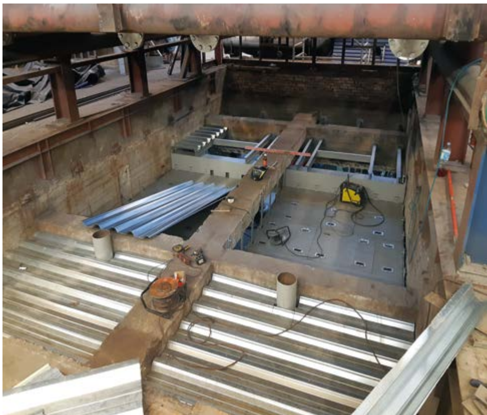
Aby zmienić system opalania kotła, należało zdemontować i przebudować całą jego dolną część.
