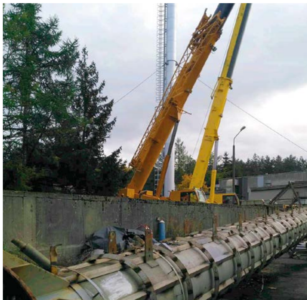
Na pierwszym planie widoczny stary, wyeksploatowany komin sianowskiej kotłowni.
