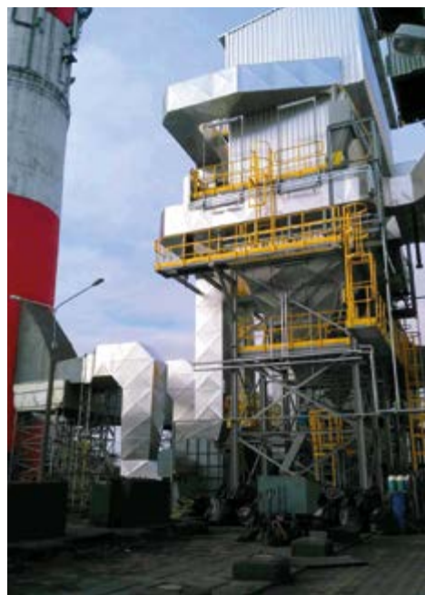
Tak prezentuje się nowy system odpylania workowego, który praktycznie całkowicie usuwa pył ze spalin.
