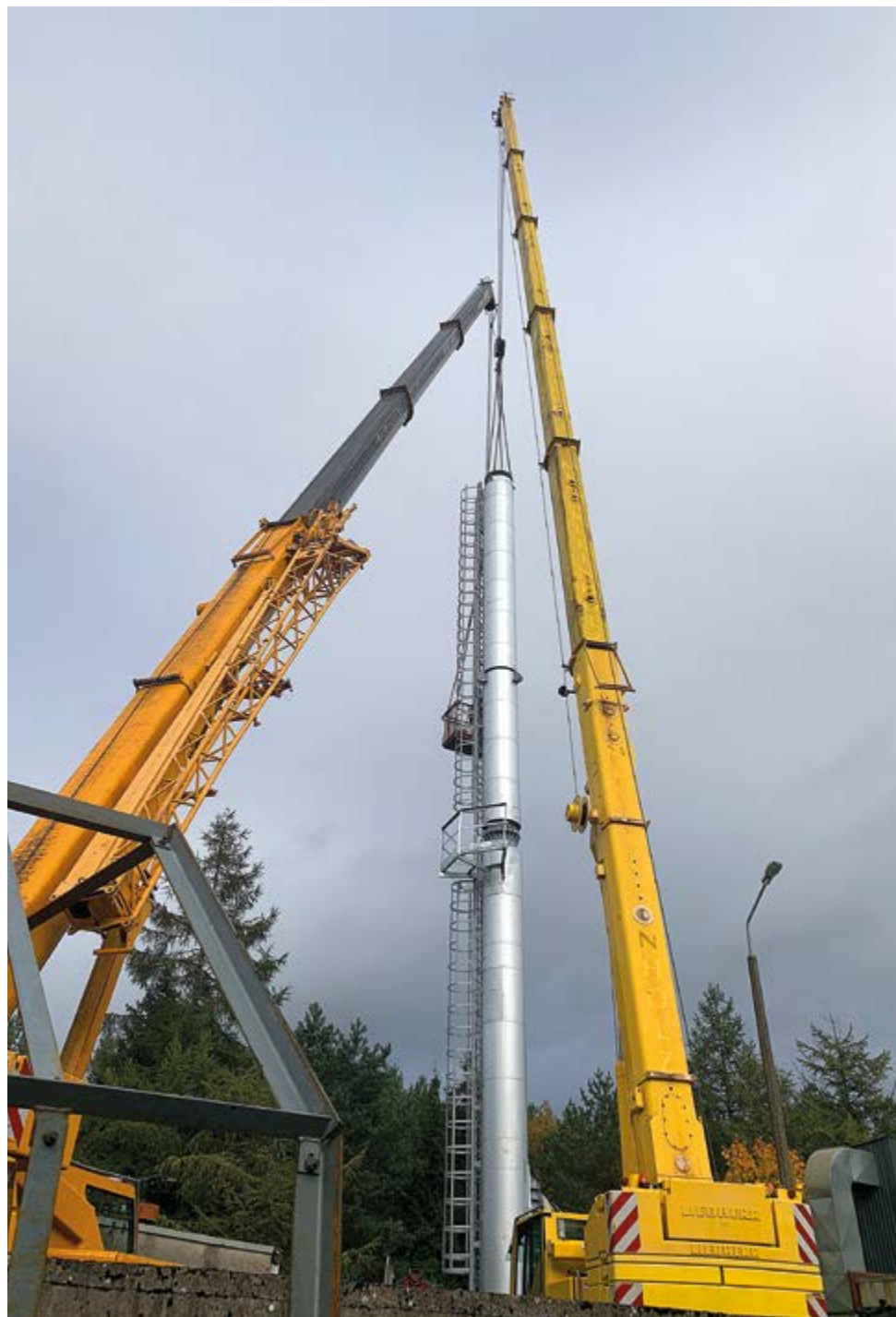
Montaż poszczególnych segmentów nowego komina w Sianowie.
