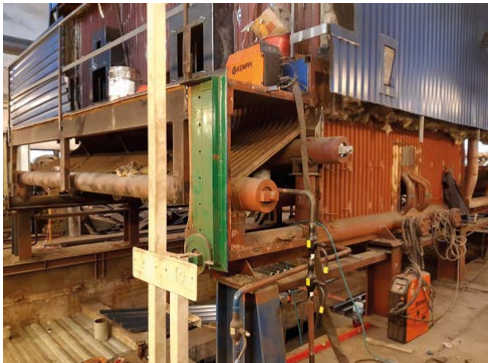
Przebudowa kotła wysokiego na kilkanaście metrów nie jest łatwym zadaniem.
